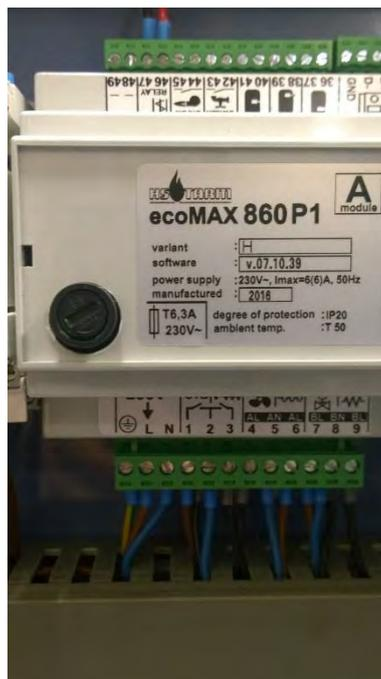
Celui-ci fond lors d'une surtension ou surintensité et doit être remplacé par un identique. Contactez votre installateur ou un électricien si le fusible "grille" fréquemment.
