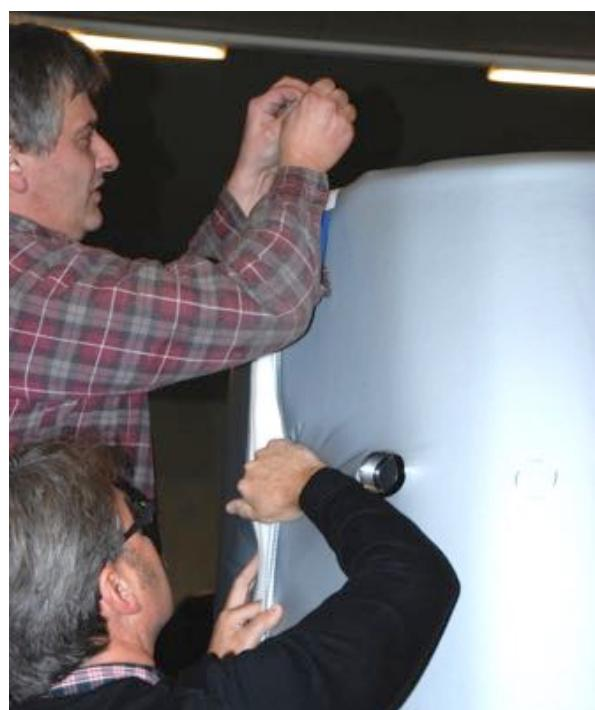
**HINWEIS** Die Isolierung bei den Muffen 1 – 3 einhängen, festhalten und kräftig an den Puffer andrücken. Anschliessend die Isolierung spannen und straff um den Puffer legen. Unbedingt darauf achten, dass zwischen Isolierung und Puffer kein Zwischenraum entsteht. Falls nötig, die Isolierung durch Drücken und Klopfen mit der flachen Hand straffen.
