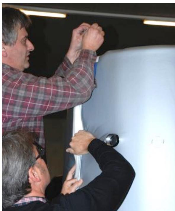
**REMARQUE** Placer l'isolation autour des manchons 1 à 3, bien tenir et l'appuyer fermement sur le ballon de stockage. Ensuite, tendre l'isolation et la placer tendue autour du ballon. Veillez absolument à ce qu'il n'y ait pas d'espace entre l'isolation et le ballon de stockage. Au besoin, tendre l'isolation en appuyant et tapotant avec le plat de la main.
