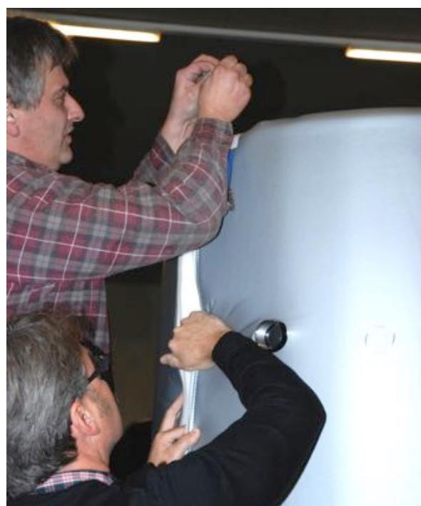
**AVVERTENZA** Fissare il materiale isolante ai manicotti 1 – 3 e premere con forza l'isolante sul serbatoio tampone. Infine tendere l'isolante passandolo attorno al serbatoio e facendolo aderire bene all'apparecchio. Fare attenzione a non lasciare spazi intermedi tra l'isolante e il serbatoio. Se necessario, premere l'isolante con il palmo della mano per farlo aderire perfettamente.
