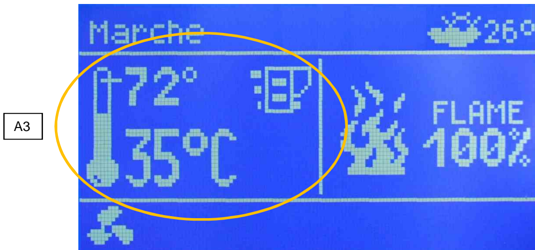
A3 : Température de consigne chaudière (ici 72°C) et température actuelle chaudière (ici 35°C)
