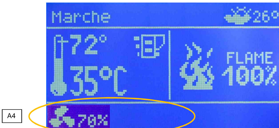
A4 : Ventilateur en fonctionnement ( ici à 70%).
