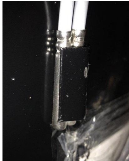
Fixation de 2 sondes, plaquette frappée au marteau
